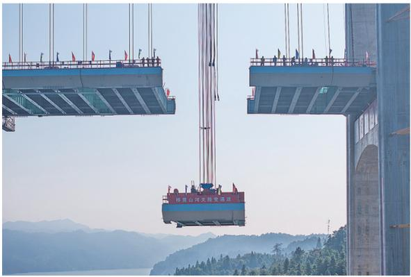
8月3日，随着最后一段200余吨重的钢混结合梁被缓缓提升，由湖南路桥建设集团承建的张官高速控制性工程洞庭溪沅水特大桥主桥顺利合龙，为2026年全线通车奠定了坚实基础。据了解，洞庭溪沅水特大桥位于湖南怀化沅陵县境内，全长1707米，主桥长800米，为双塔单跨悬索桥。
