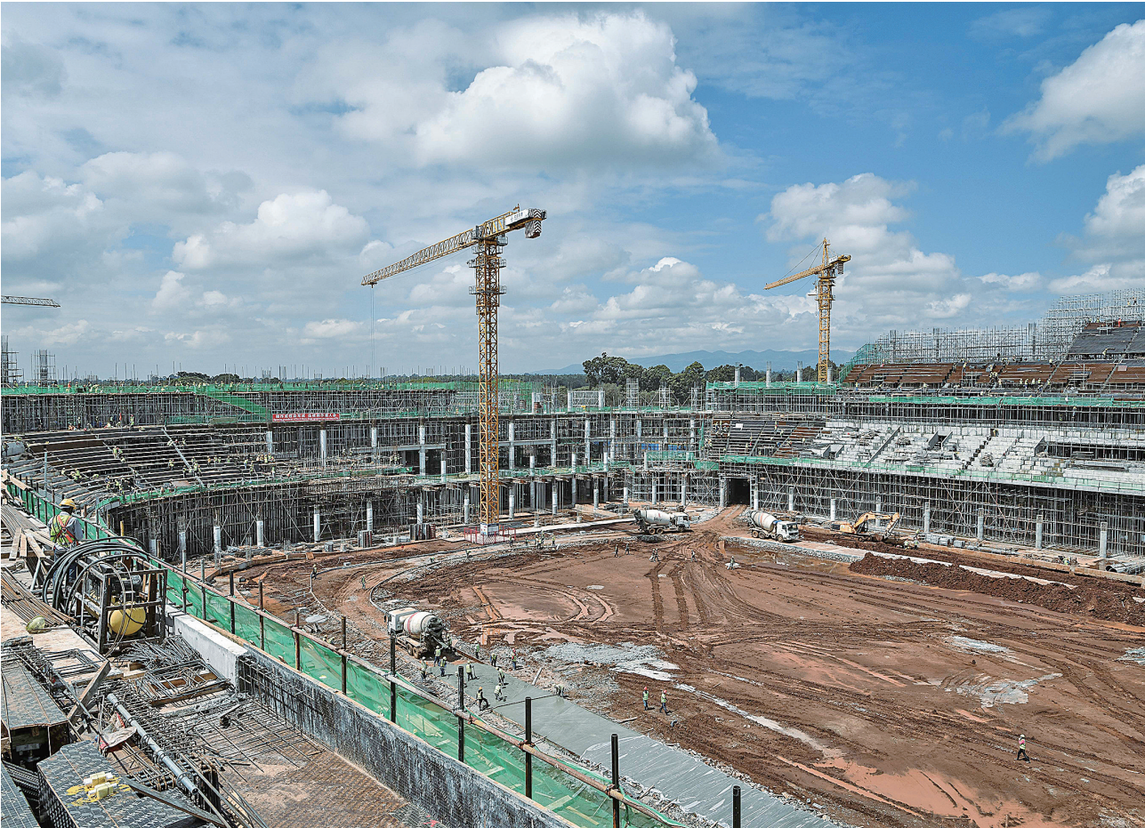
塔兰塔体育城项目位于内罗毕,主体为6万个座位规模的国际足联标准专业足球场,计划作为2027年非洲国家杯足球赛(非洲杯)主要体育场之一举办开闭幕式 and 比赛等。该项目由中国路桥工程有限责任公司承建,预计2025年年底完工。图为3月18日在肯尼亚首都内罗毕拍摄的塔兰塔体育城项目施工现场。(新华社记者 韩旭 摄)
