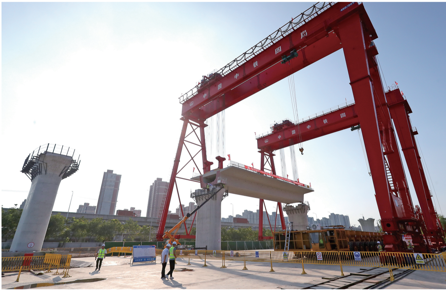
8月26日,由中铁四局承建的沪渝蓉高铁上海段首幅箱梁架设完成,标志着该段正式进入桥梁架设阶段。上海段是沪渝蓉高铁东段线路的重要组成部分,沪渝蓉高铁东段线路项目建成后,对于优化沿江地区铁路网布局、服务长江经济带协同发展,推动长三角高质量一体化发展具有重要意义。
