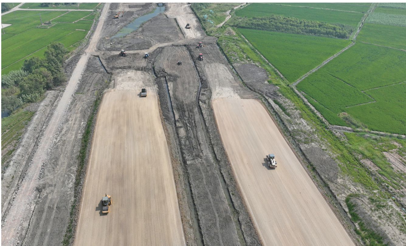
眼下,范蠡大道北延二期新建工程路基建设加快推进,预计明年下半年进入路面工程阶段。该工程起于S341周杨公路,终点接常州市青洋路,全长约9.67公里,是宜兴连接无锡、苏州、常州等周边城市的主要交通干线。建成后,将进一步完善我市干线公路网络,推动我市路网更好融入苏锡常快速路网体系。
