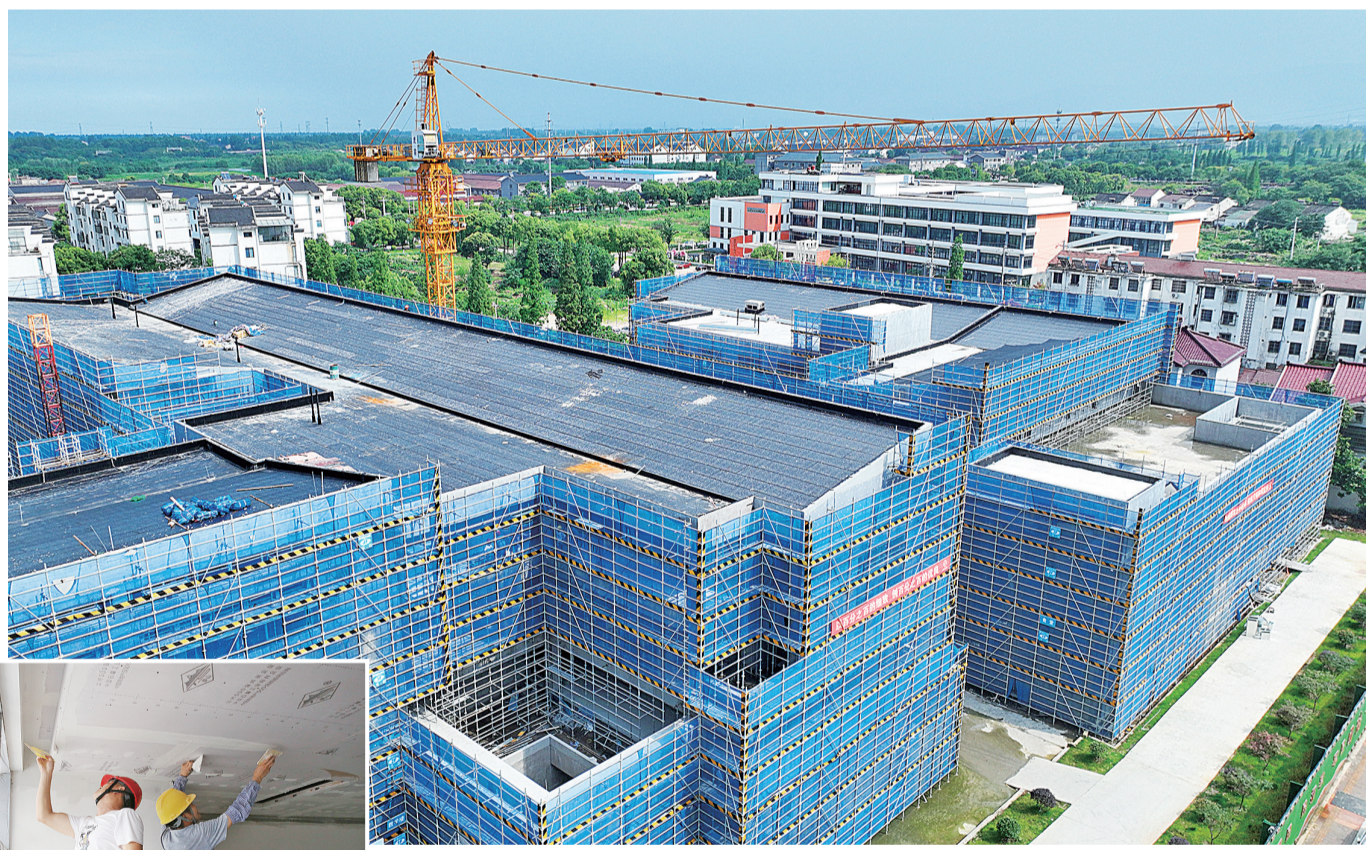
眼下,位于丁蜀镇的市东坡中学新建工程主体结构已完工,目前正在室内外装修装饰作业。该工程于去年8月中旬开工,建筑总面积近3万平方米,总投资超1.5亿元,预计将于今年年底竣工验收。
