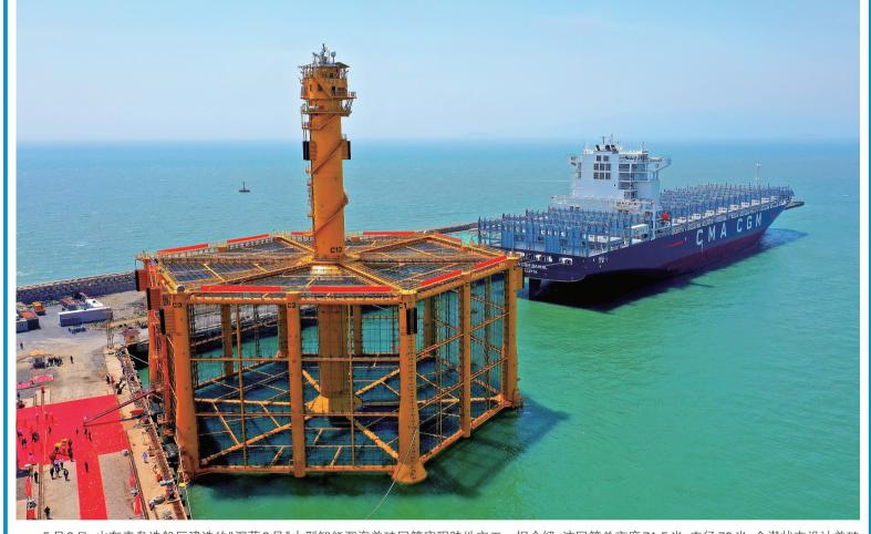
5月9日,山东青岛造船厂建造的"深蓝2号"大型智能深海养殖网箱实现陆地完工。据介绍,该网箱总高度71.5米,直径70米,全潜状态设计养殖 水体达9万立方米,是目前我国应用海域最远、适用水深最深、养殖水体最大、功能性能最先进的深远海养殖网箱装备。该养殖网箱通过搭载自动投喂 系统、水文水质气象测量系统、水下成像系统、水下补光系统及生物量监测系统等智慧化养殖设备,可实现陆海联动,搭建一体化数字化管理模式,逐 步实现深远海无人养殖功能。
