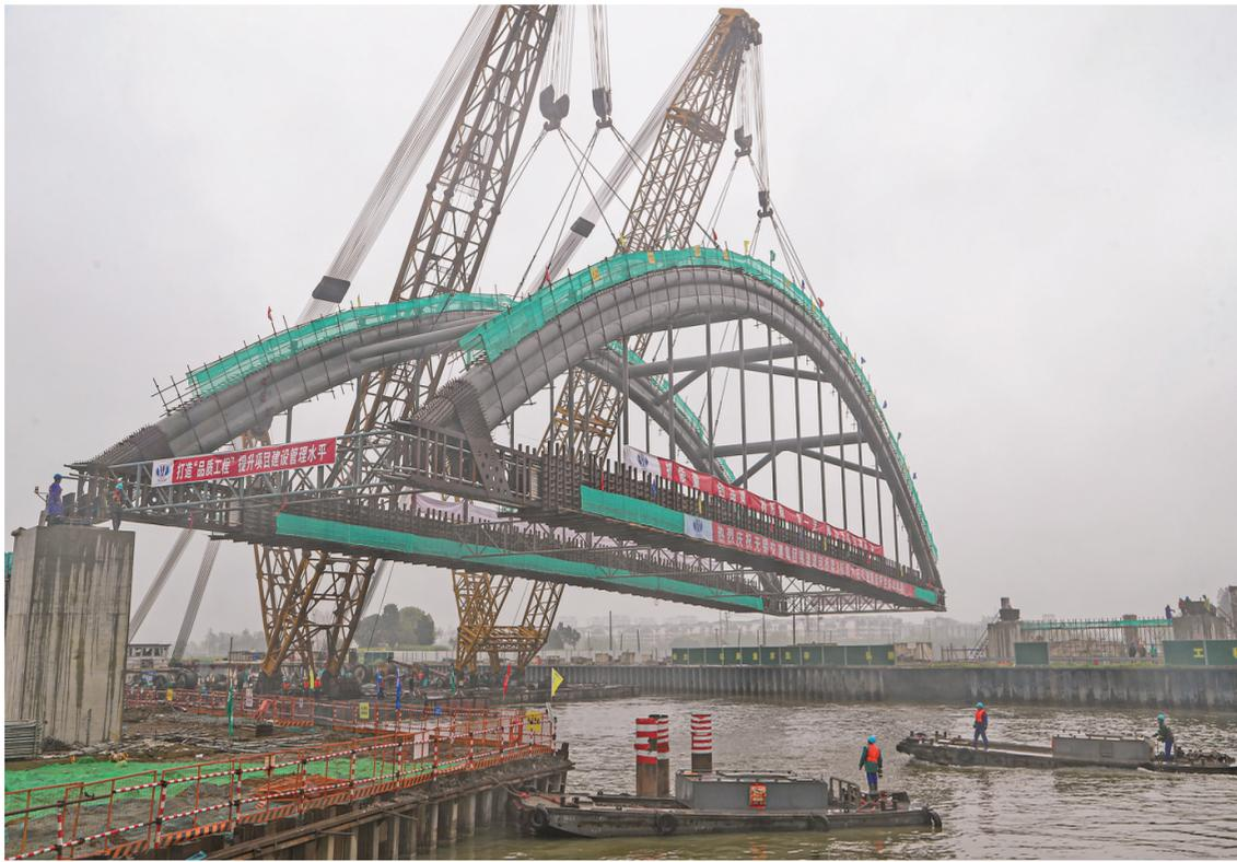
本报讯(记者徐卿尧/文 翟霄帆/摄)4月8日上午,在锡漂漕河配亭段,两艘大型浮吊船将六庄桥主桥钢结构从拼装场地上吊起(如图),并准确无误地安放至预定位置。至此,横跨锡漂漕河的六庄桥主桥顺利完成吊装,标志着项目主桥全面进入上部结构施工阶段,预
