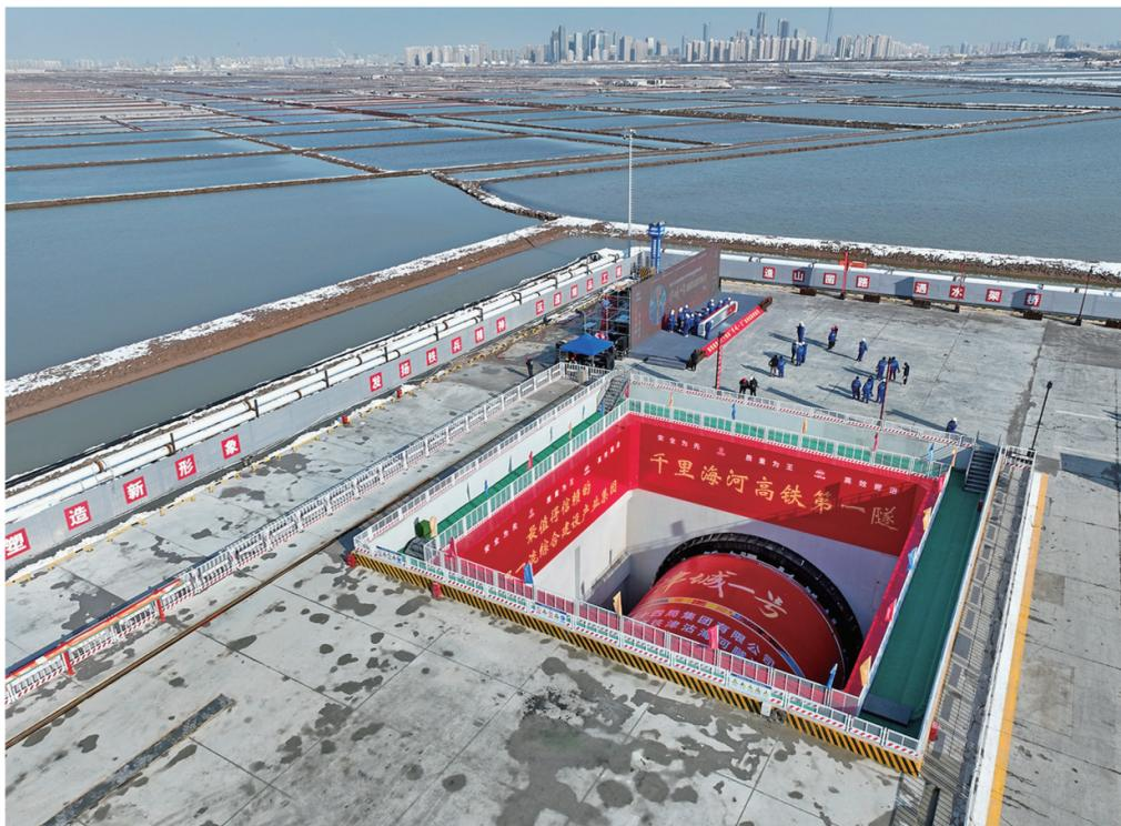
1月18日,由中铁十四局承建的津潍高铁津海河隧道超大直径盾构机“津城一号”顺利始发,标志着京津冀地区开挖直径最大、掘进距离最长的高铁盾构隧道正式开始掘进。津潍高铁起自天津枢纽滨海站,终至济南高铁潍坊北站,正线长度348.9公里,设计时速350公里。
