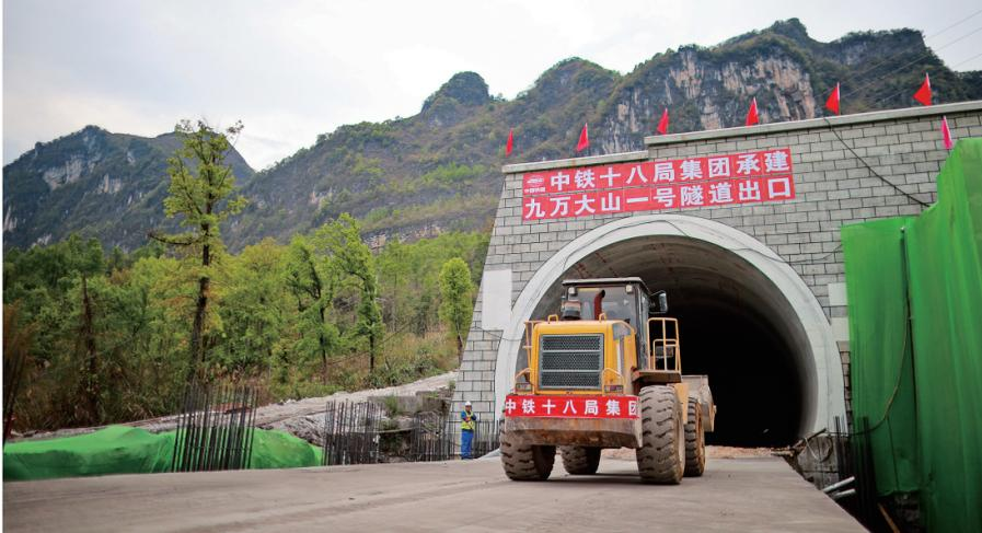
3月24日,由中铁十八局承建的贵南高铁最长隧道九万大山一号隧道顺利贯通。据了解,该隧道全长17012米,施工难度大,是全线重要控制性工程,此次贯通为贵南高铁全线贯通奠定基础。贵南高铁设计时速350公里,是我国“八纵八横”高速铁路主通道包头至海口通道的重要组成部分。图为3月24日,施工车辆驶出九万大山一号隧道。(新华社记者 刘续 摄)
